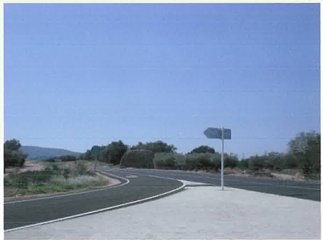
Vista panoràmica des de la nova carretera de Freginals a Amposta en direcció a Freginals a l'emplaçament
