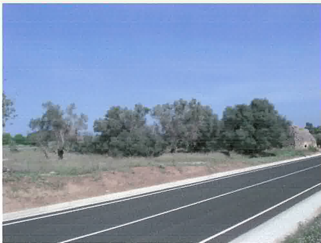
Vista panoràmica des de la nova carretera de Freginals a Amposta en direcció a Amposta a l'emplaçament
